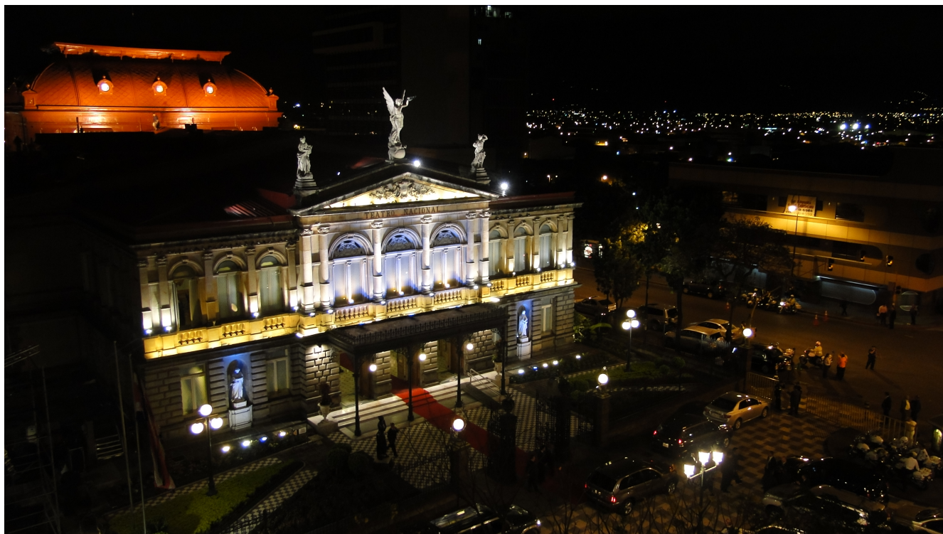
Fotografía: Ana Mariela Rodríguez. Presentación pública de la conclusión de obras de restauración de la cúpula del Teatro Nacional de Costa Rica. Mayo 2011
